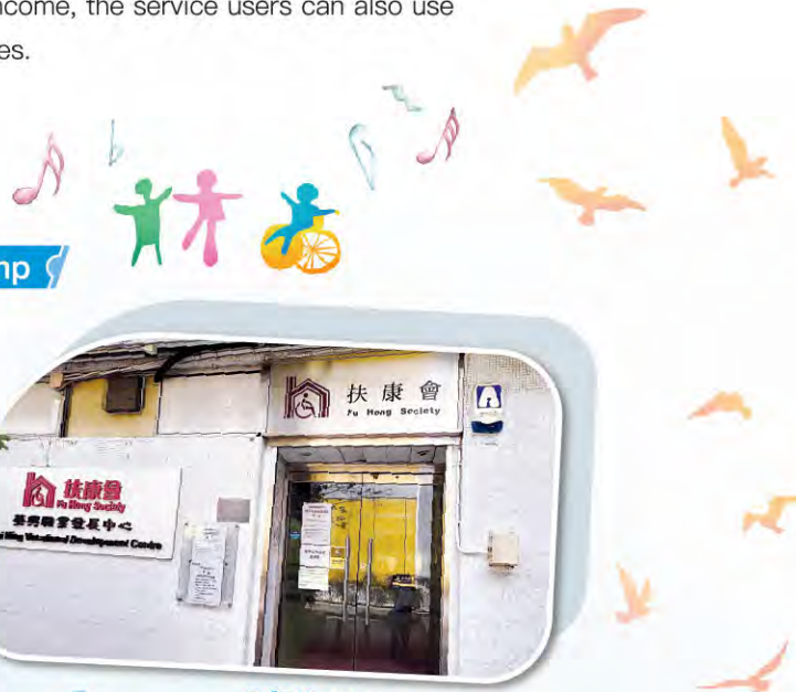
工程前 Before the revamp
